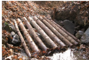
土留めの完成
