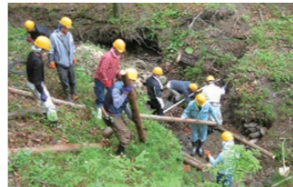
崩壊した沢筋に間伐材を使用している様子
